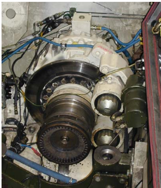
Bild 3: Federspeicherbremse am Verteilergetriebe: Erst sichtbar nach Ausbau des Powerpacks
